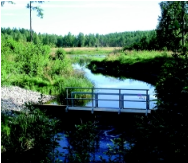
Utloppet till Jädraån efter våtmarksanläggningen.
